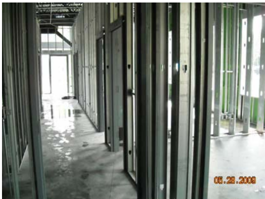
Interior Stud Wall Framing
